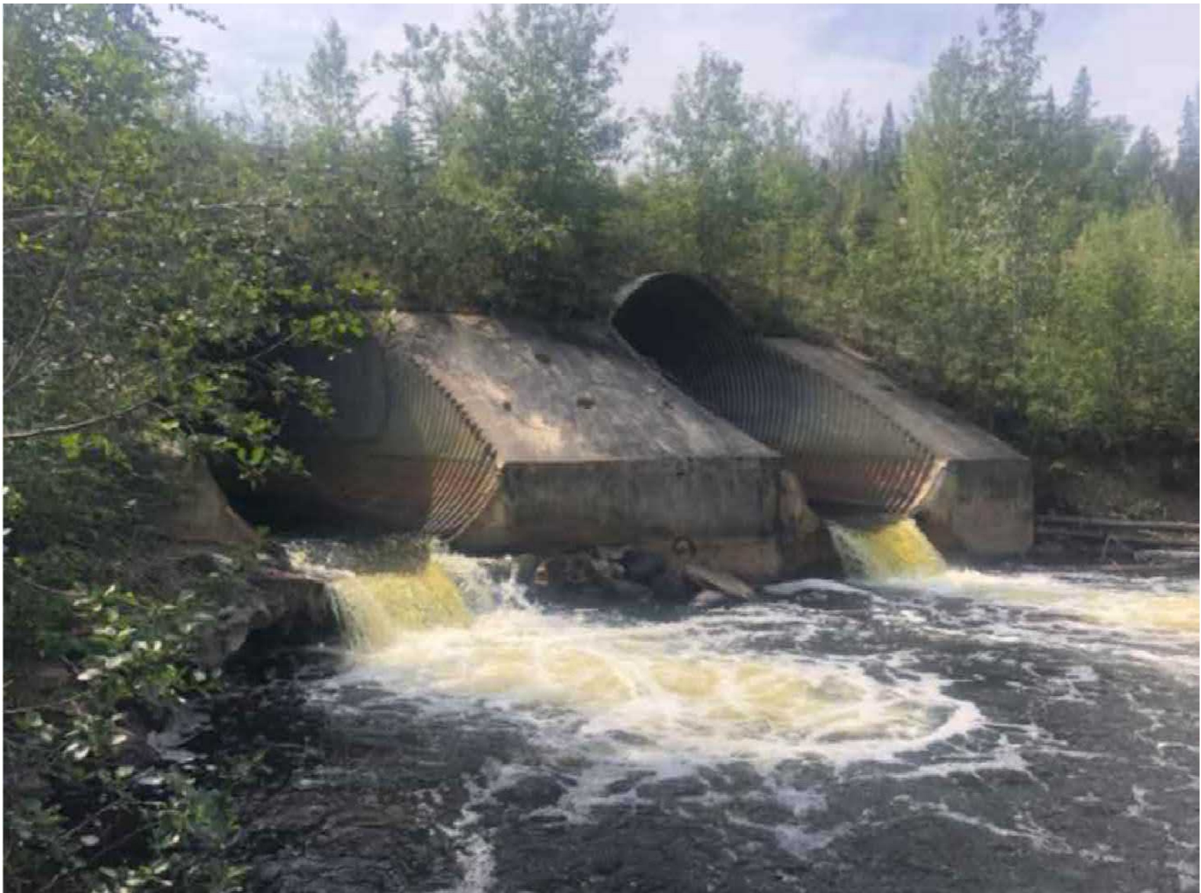
CULVERT OUTLET N.T.S
